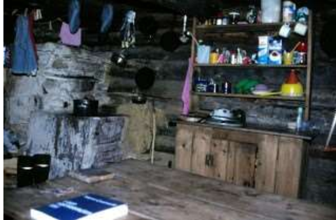
Kuvassa vasemmalla iso luonnonkivistä muurattu lämpöä hyvin keräävä tulisija
